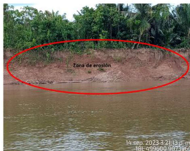
FIGURA N°03: MARGEN DERECHA DEL RIO AGUAYTIA ZONA EROSIONADA
